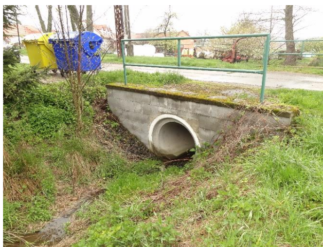
Propustek pod ohroženou komunikací.
