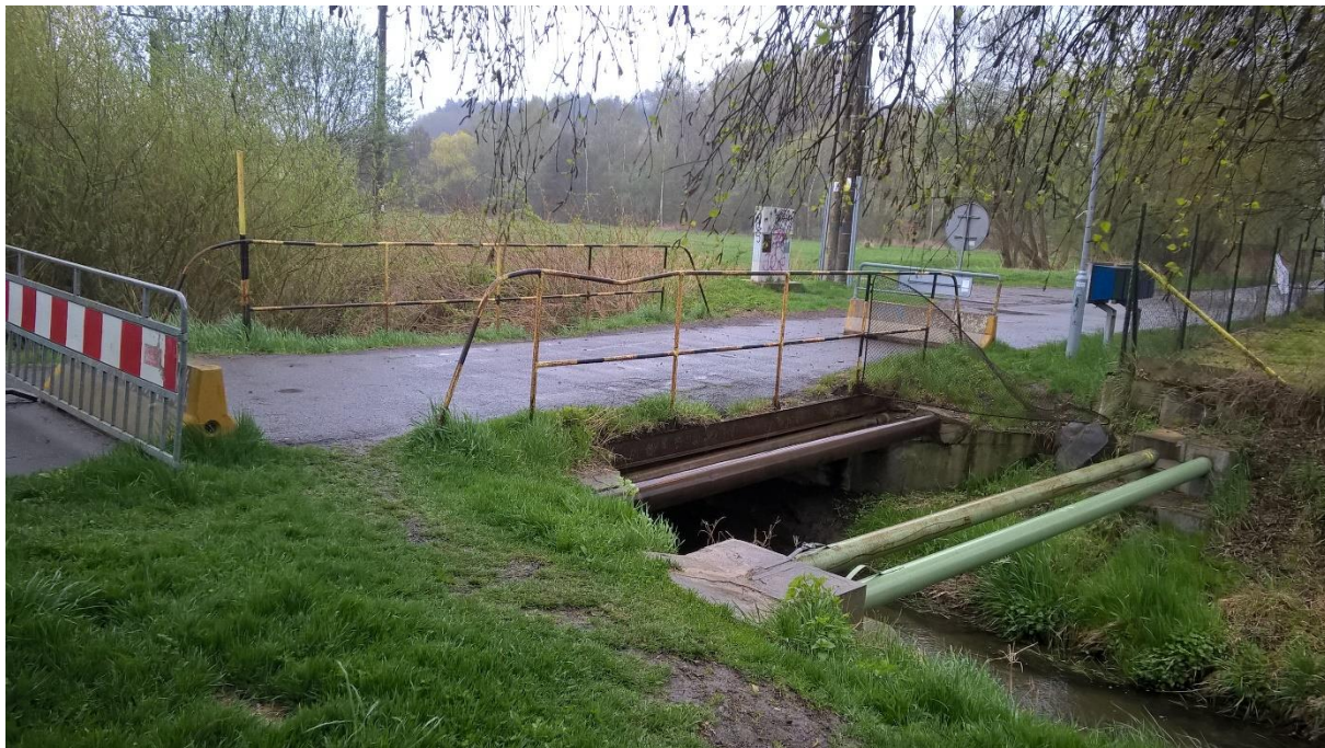
Obrázek 2: Most ve sportovní ulici, který snižuje kapacitu koryta Mnichovky
