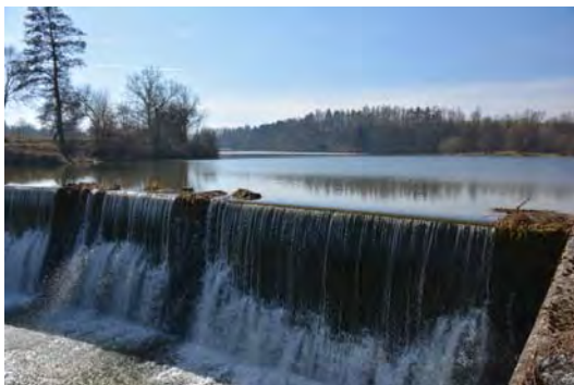
Kamberský rybník – bezpečnostní přeliv s velkou kapacitou průtoku
