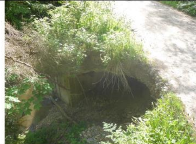
Podemletí základu mostu a silnice v úseku Drahňovice - Poříčko stále čeká na opravu
