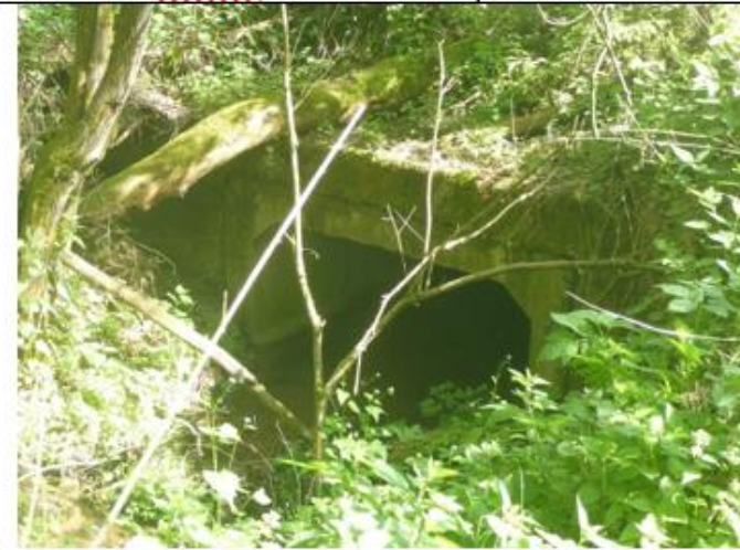
Ucpáný propustek způsobil vybřežení toku na komunikaci, avšak nezpůsobil žádné škody (soutok Drahovické svodnice a Křešického potoka )
