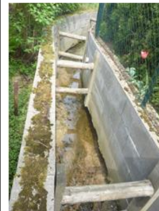
Lokalita Rousínov, opevnění koryta se vzpěrami a problémové pozemky
